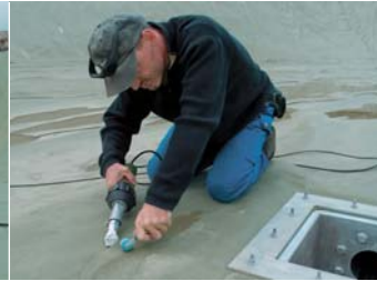
Soudage des raccords avec le TRIAC PID et une buse large emboîtée.
