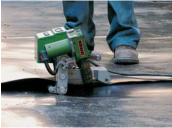
TWINNY T avec panne combinée pour le soudage d'un lé d'étanchéité en HD-PE.
