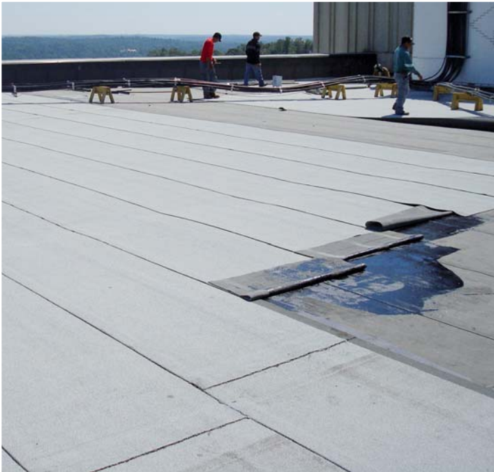
1. Flamme nue interdite Une alternative fiable à la flamme nue pour les systèmes de toitures froides.
