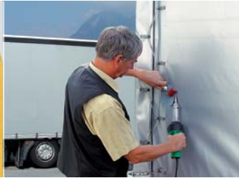
Réparations par soudage d'une bâche de poids lourd avec TRIAC PID, une buse large et un rouleau de pression.
