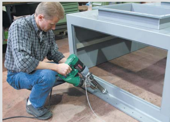
Réparations avec FUSION 3C
