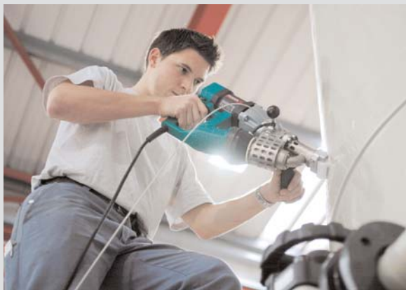
Construction de réservoirs avec FUSION 2
