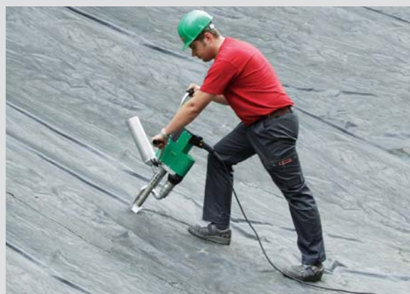
Aménagement de décharges avec WELDPLAST G6 (avec filtre à granulés)
