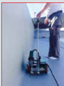
ROOFON « R » en Piscine
